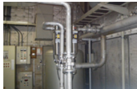
ループ化した配管
