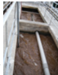
排水処理ブローアの様子 〔株)オクトス〕
